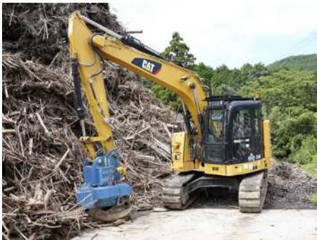
0.45 バックホー（グラブ装置付）3 台
